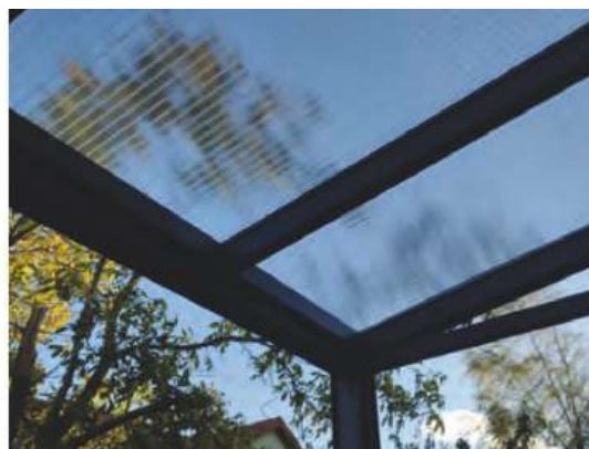
Poliwęglan bezbarwny jednokomorowy 16 mm
